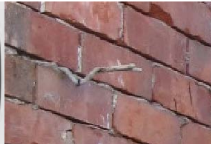
(d) V-drip flat fishtailed wall ties
